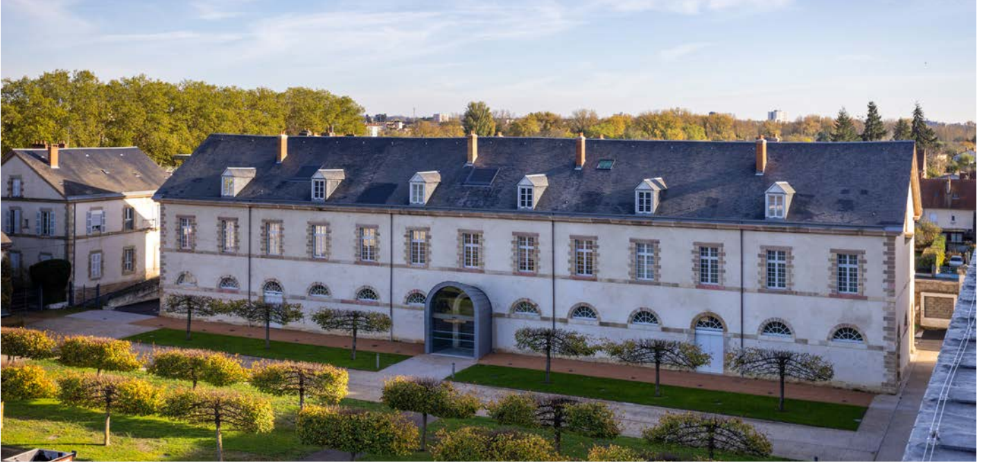
Le bâtiment réhabilité sur le site du CNCS © Joël Bonnard
